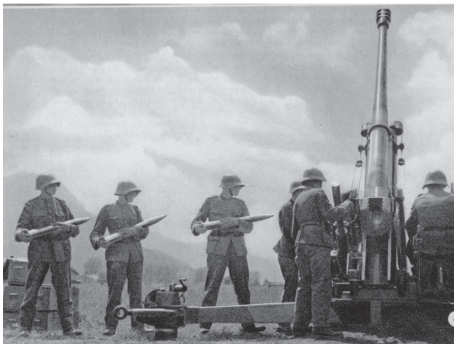
Die 7,5-cm-Kanone beim Schiessen. Links vom Rohr sieht man ein Geschoss, das in der Tempier-Maschine eingestellt wird.
