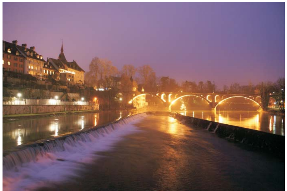
Im Jahr 1876 wurde Bremgarten West mit einer Normalspurlinie mit Wohlen verbunden. 1902 wurde die wichtigere Linie nach Zürich durch die Schmalspurbahn (1000mm) geschaffen. Im Jahr 1912 wurde dann diese Eisenbahnbrücke über die Reuss gebaut und die beiden Linien verbunden.
